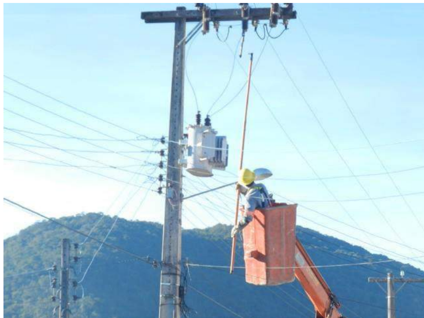
Figura 4.2. Manobra de CF queimada. Fonte: Nota técnica - Aspectos técnicos de O&M - CELESC
